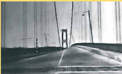
Die Tacoma Bridge schaukelt sich auf.
