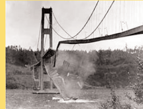
Einsturz der Tacoma Bridge.
